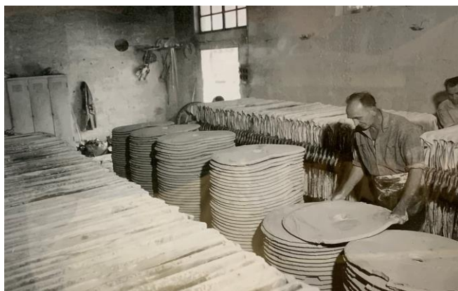
Foto 09: dischi di argilla in uscita dalle filtropresse (foto Museo geomineralogico e del caolino)
