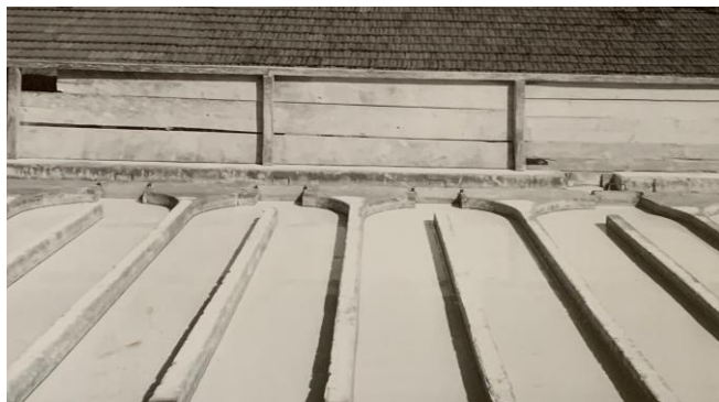
Foto 08: canalette per la de-sabbiatura delle argille (foto Museo geomineralogico e del caolino)
