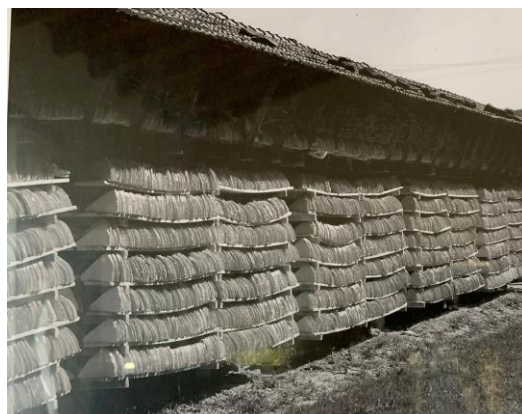
Foto 10: pani di argilla posti ad essiccare sotto le tettoie della cava (foto Museo geomineralogico e del caolino)
