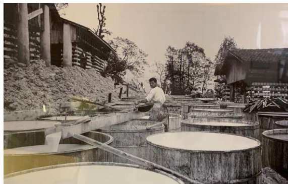
Foto 07: tinozze per il lavaggio e la decantazione delle argille (foto Museo geomineralogico e del caolino)
