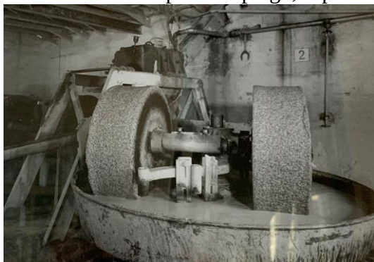
Foto 07: macinazione del materiale estratto dalla cava (foto Museo geomineralogico e del caolino)
