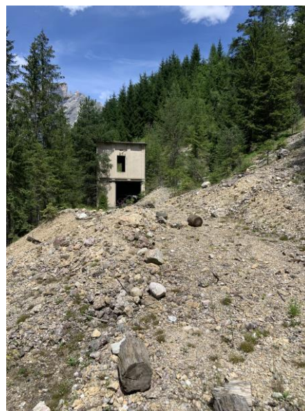
Foto 02: resti di vecchie strutture minerarie – luglio 2022 (foto A. Canal)
