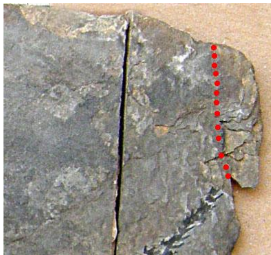
Foto 04: particolare della frattura e della parte in eccedenza
